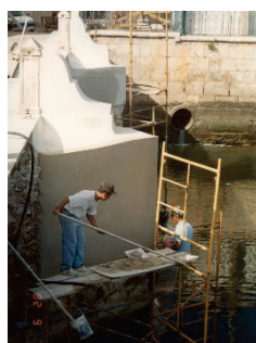
Figura 6 - Reboco e acabamentos
