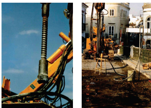
Figura 3 - Furação inicial para execução das injeções de consolidação
