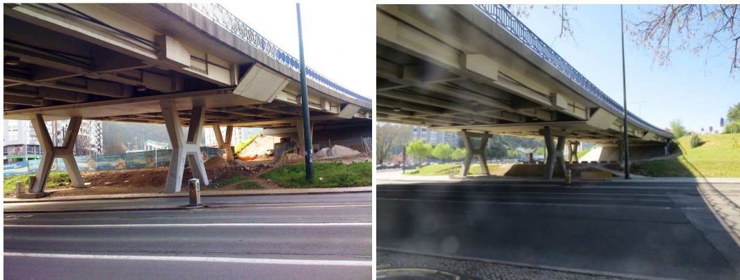
Figura 13. Vista do viaduto antes e após a intervenção
