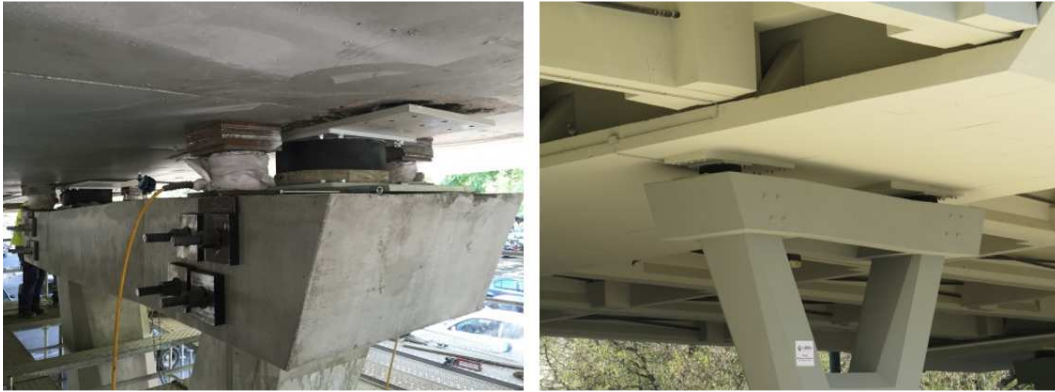
Figura 8. Montagem dos novos aparelhos de apoio em pilares (durante e após)
