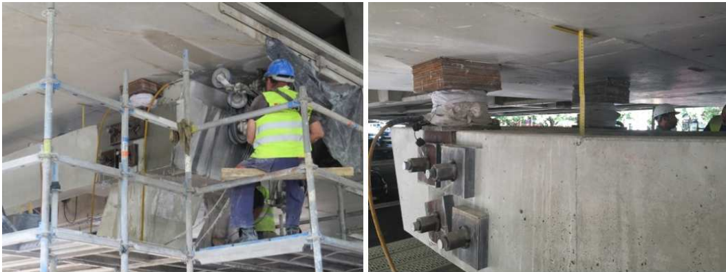
Figura 6. Corte do topo dos pilares com fio diamantado (durante e após o corte)
