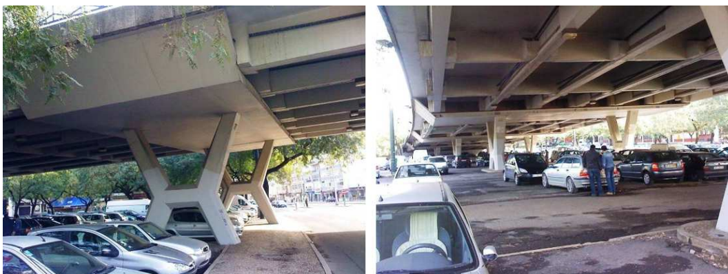
Figura 1. Fotografias do viaduto antes da intervenção
