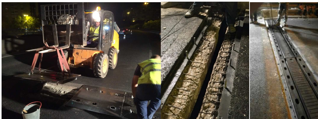
Figura 11. Montagem das juntas provisórias para assegurar a circulação diurna e introdução das novas juntas de dilatação nos encontros
