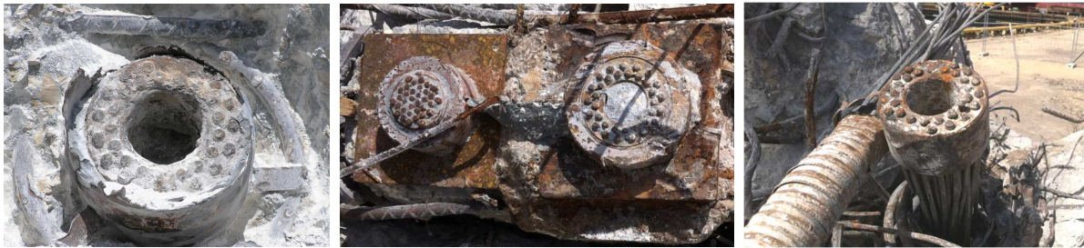
Fig. 5 – Ancoragens dos cabos de pré-esforço das vigas
