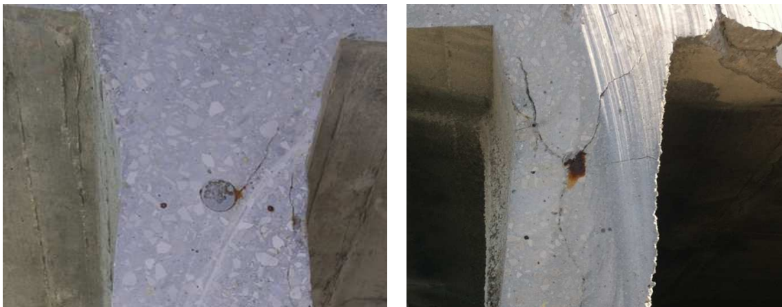
Fig. 10 – Início da formação de fendas a partir do cabo ainda sem atingir as faces da alma
