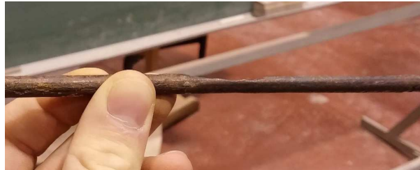
Fig. 15 – Exemplo de um fio de pré-esforço ensaiado com perda de secção devida à corrosão
