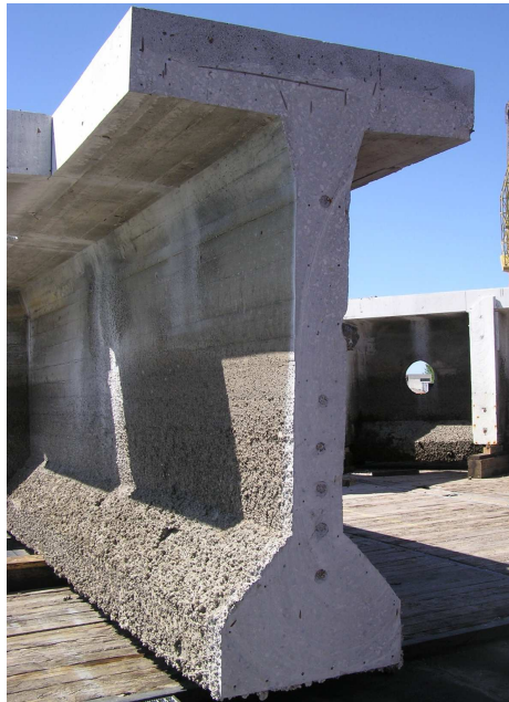
Fig. 7 – Cabos de pré-esforço de uma viga intermédia
