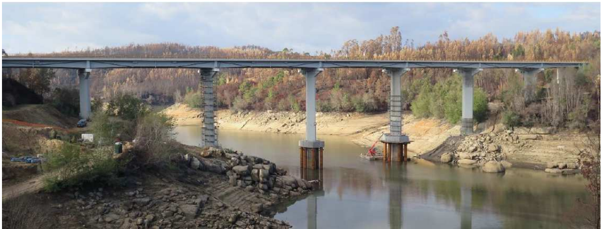
Figura 9. Vista geral dos trabalhos de intervenção nos pilares.
