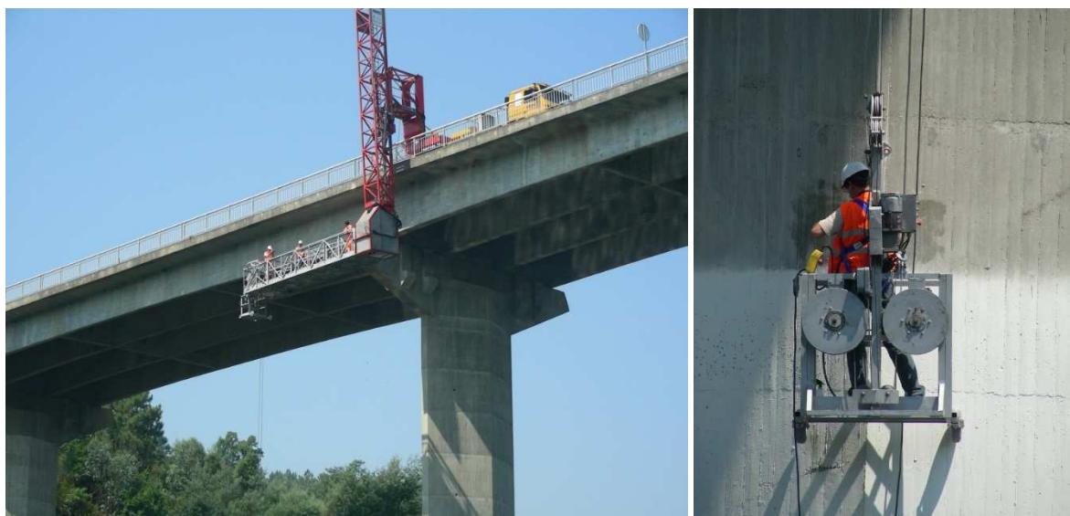
Figura 4. Plataforma de inspeção.
