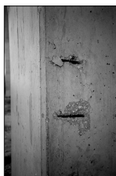
Cintas expostas devida à corrosão no pilar P12
