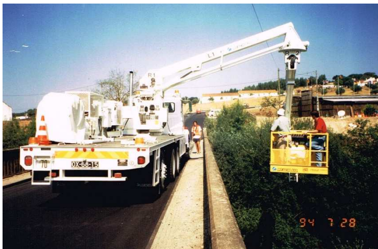
Figura 5 - Veículo de inspeção na ponte
