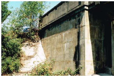
Figura 11 - Fendilhação nos encontros
