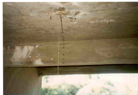
Figura 6 – Estalactites associadas às infiltrações de água e arrastamento de cálcio Figura 7- Escorrimentos de água do tabuleiro
