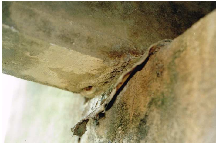
Figura 10 - Apoios de chumbo em vigas do tabuleiro
