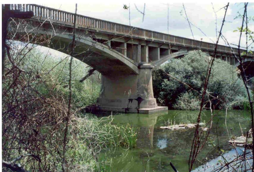
Figura 1 – Vista geral da ponte antes do alargamento do tabuleiro
