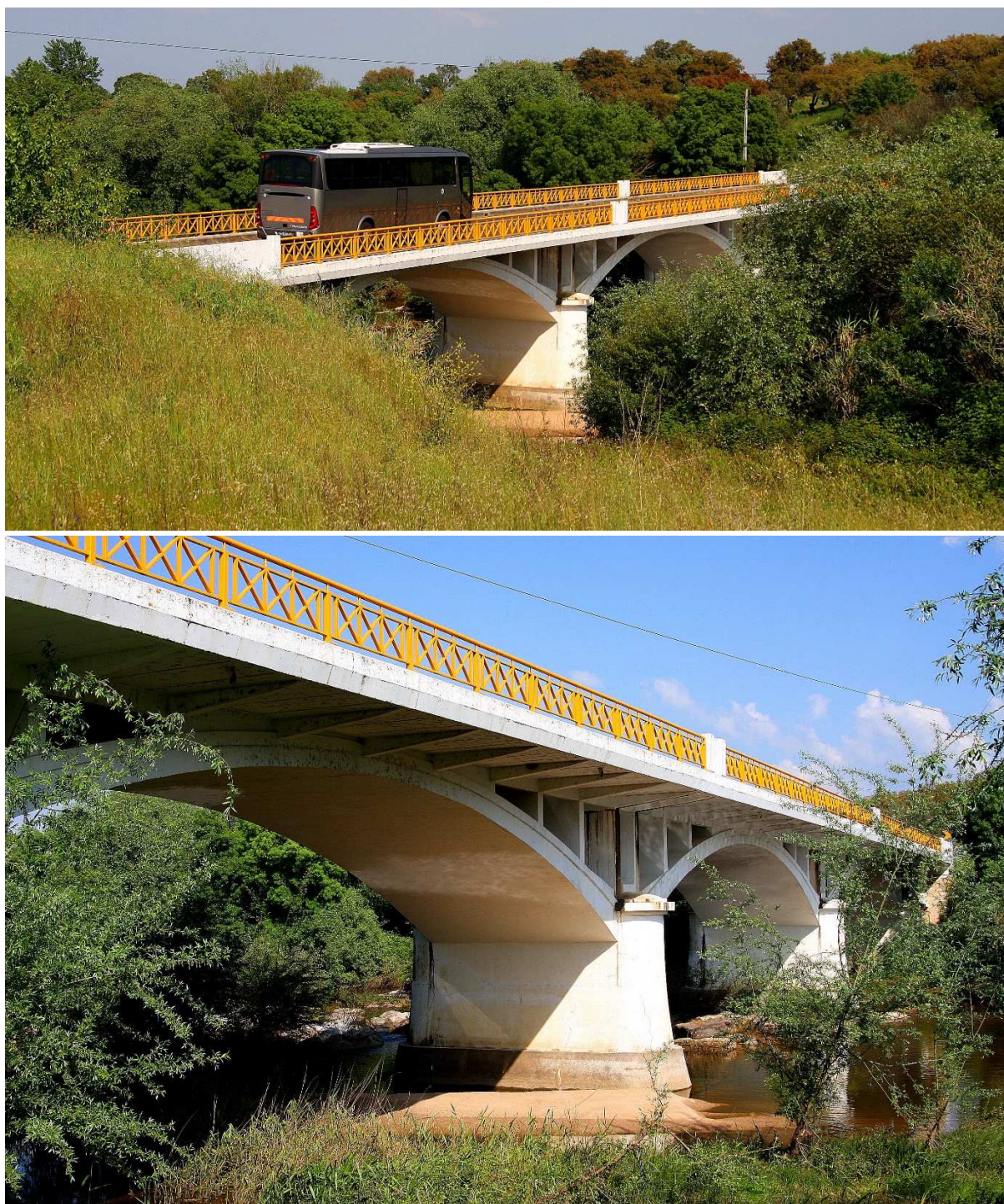
Figura 20 – Vista gerais da ponte da Chaminé após intervenção de reabilitação de 1998
