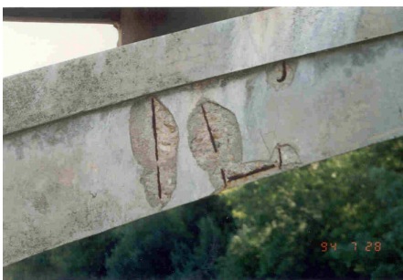
Figura 8 – Corrosão local de armaduras
