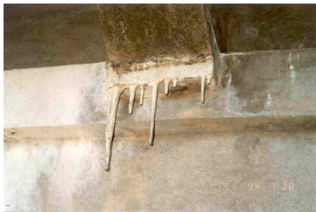
Figura 6 – Estalactites associadas às infiltrações de água e arrastamento de cálcio Figura 7- Escorrimentos de água do tabuleiro
