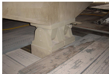
Figura 8b - Reabilitação de apoios fixos (rótulas)
