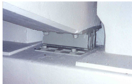
Fig. 8a - Reabilitação de apoios móveis
