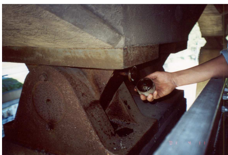
Figura 8b - Reabilitação de apoios fixos (rótulas)
