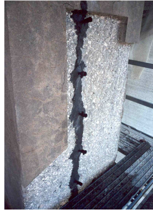
Figura 7 - Fendilhação em pilar e trabalho de injeção
