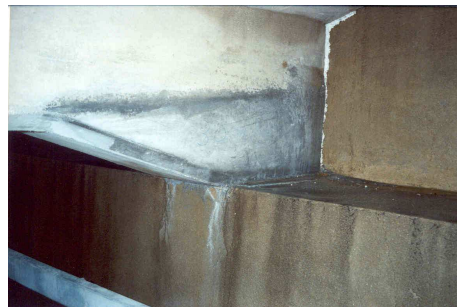
Figura 13 - Reconstrução dos topos das pilastras
