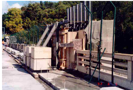
Figura 13 - Reconstrução dos topos das pilastras
