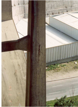
Figura 7 - Fendilhação em pilar e trabalho de injeção
