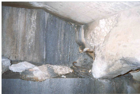
Figura 13 - Reconstrução dos topos das pilastras
