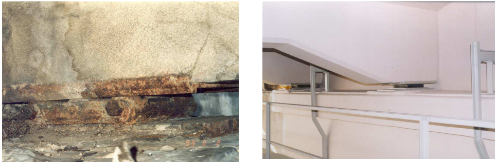
Figura 9 - Substituição de apoios móveis bloqueados e deformados
