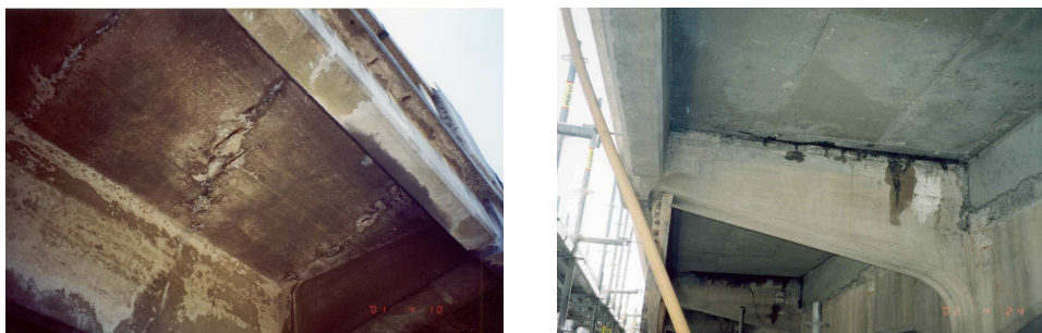
Figura 12 - Reconstrução das lajes consola dos passeios
