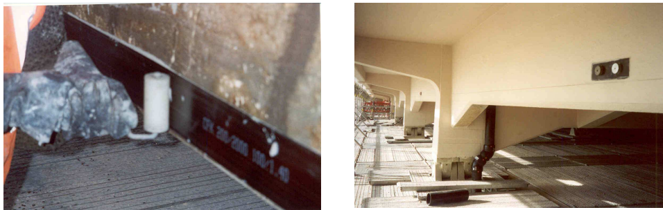
Figura 11 - Reforço das vigas e controlo de qualidade
