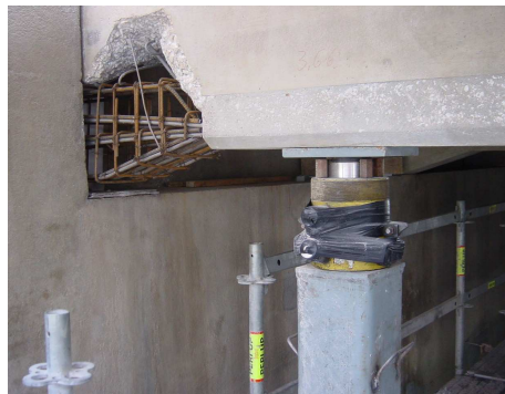
Figura 14 - Reconstrução dos topos de vigas
