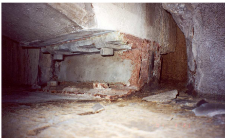
Fig. 8a - Reabilitação de apoios móveis
