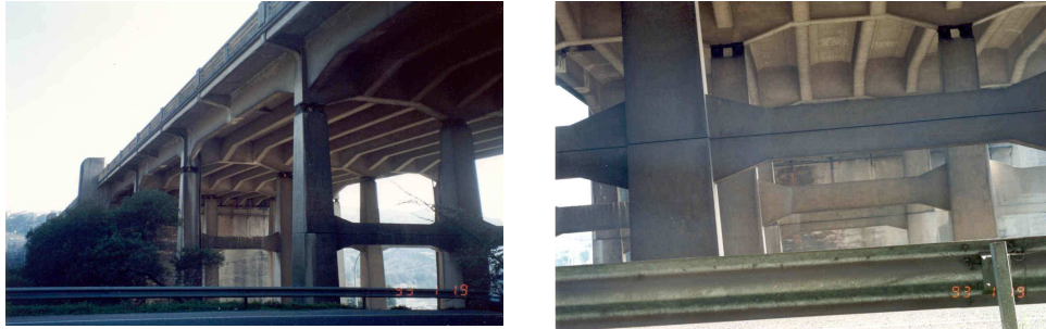
Figura 3 - Viaduto em Vigas Contínuas - Vista Inferior do Tabuleiro e dos Pilares
