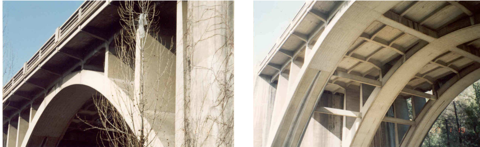
Figura 2 - Arcos Laterais - Vista Geral
