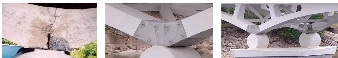
Figura 4 - Reabilitação dos apoios
