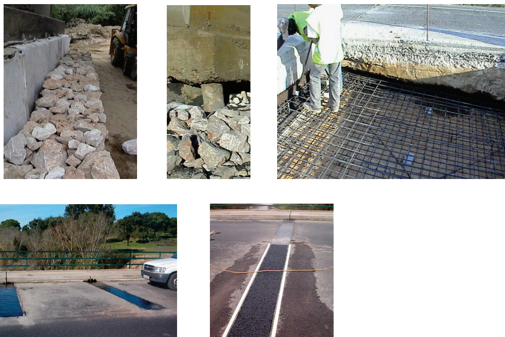
Figura 3 - Intervenções nas fundações, nova laje de transição e repavimentação
