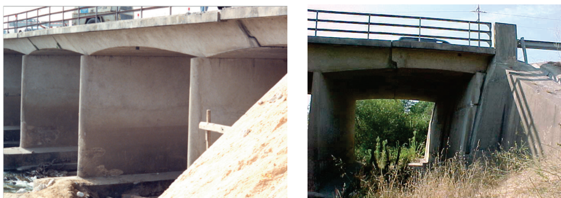
Figura 1 - Vistas gerais das pontes
