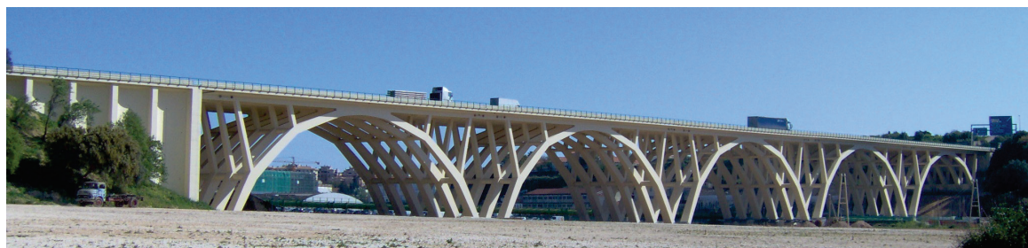
Figura 1 - Vista geral do viaduto
