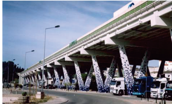
Figura 4 - Introdução de amortecimento sísmico e vista geral do viaduto após reabilitação
