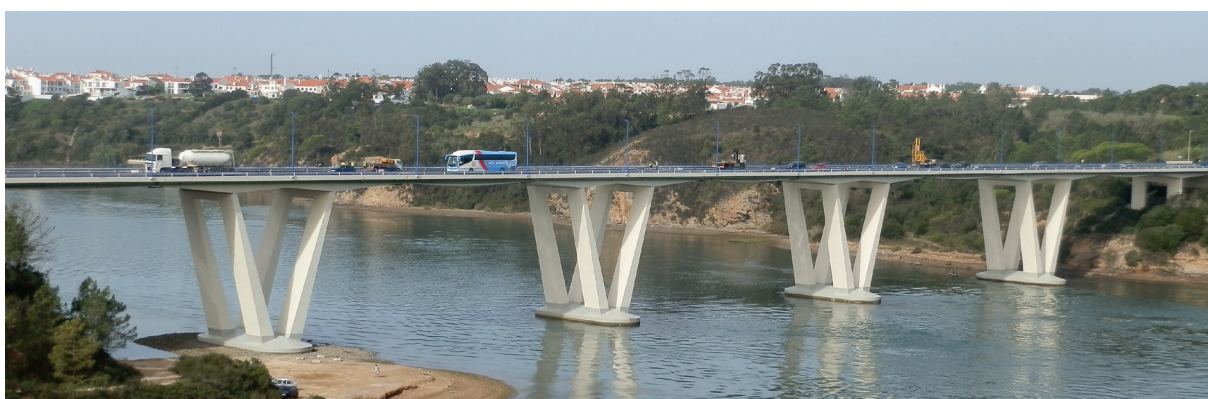
Figura 5 - Reabilitação geral, dispositivo de controlo sísmico e substituição de juntas
