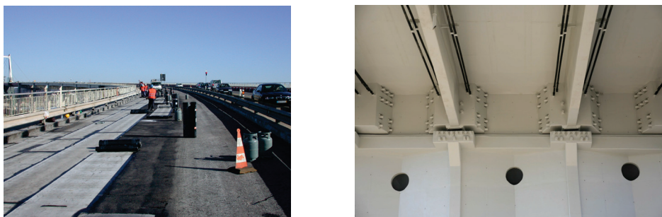
Figura 6 - Impermeabilização do tabuleiro e substituição dos apoios nos encontros
