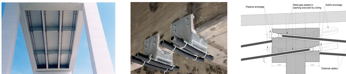
Figura 4 - Reforço com pré-esforço exterior no tabuleiro
