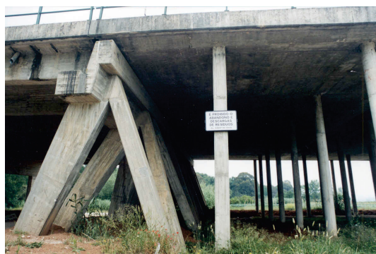
Figura 1 - Vista do Viaduto E e pilar de transição para as estacadas
