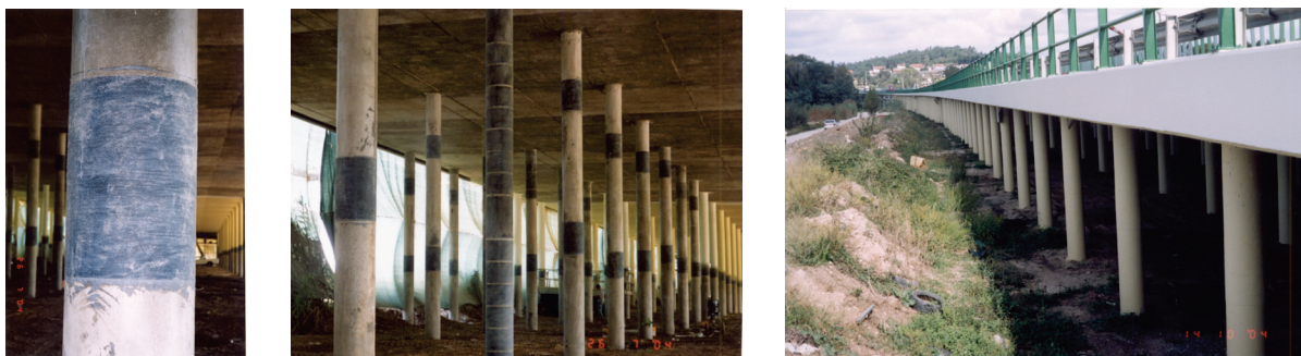
Figura 3 - Reforço dos pilares estacas com mantas de fibra de carbono
