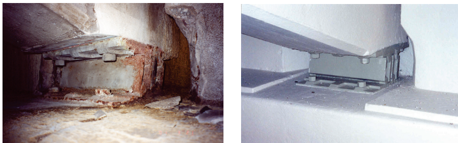
Figura 6 - Reabilitação de aparelhos de apoio móveis tipo balanceteiro
