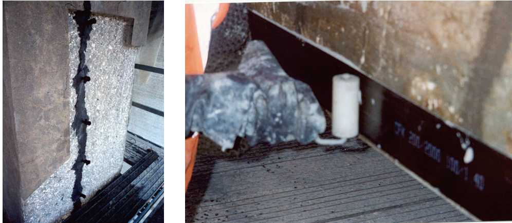
Figura 5 - Injecção de fendas em pilares e reforço de vigas com laminados de fibra de carbono
