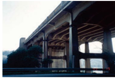
Viaduto em vigas contínuas
