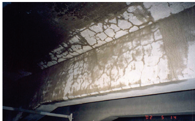
Figura 4 - Fendilhação típica das reacções alcalis sílica
