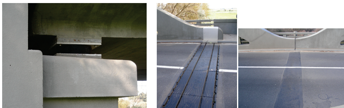
Figura 3 - Novos aparelhos de apoio HDRB e novas juntas de dilatação
