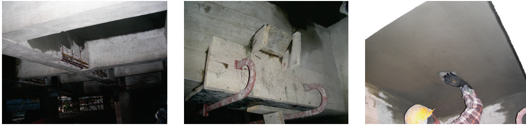
Figura 4 - Reparações locais e protecção geral da ponte
