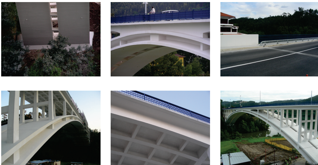
Figura 5 - Aspectos gerais da ponte após a intervenção
