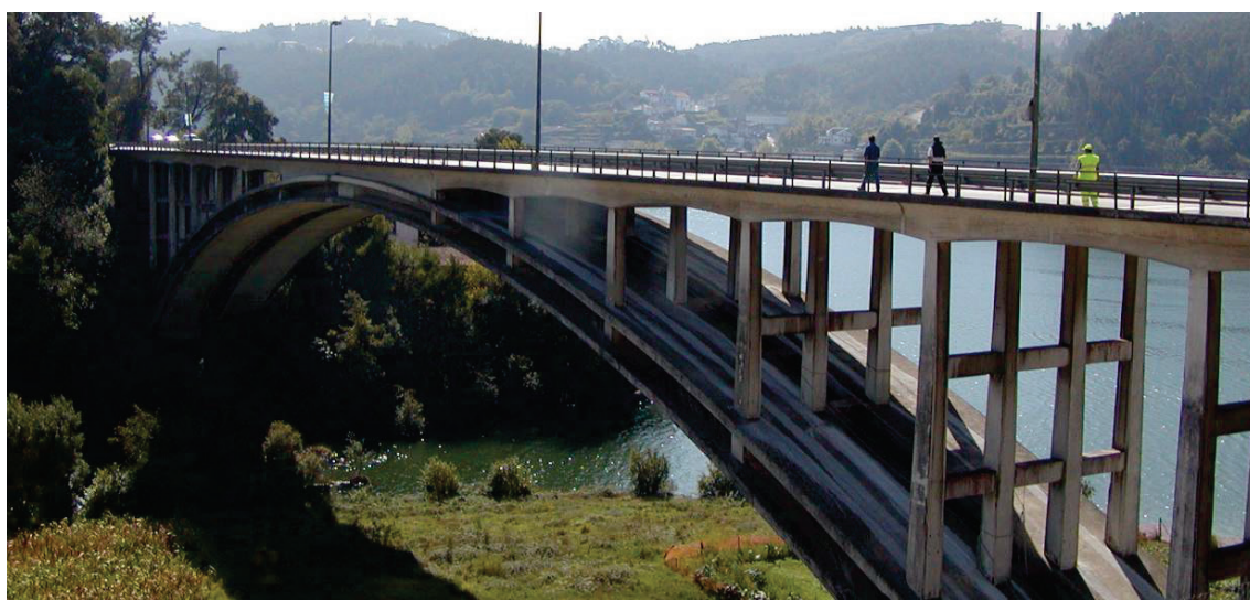
Figura 1 - Vista geral da ponte
