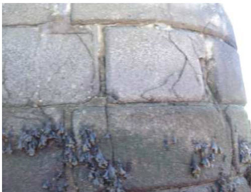
Fig. 5 – Abertura de juntas e fendas em blocos de cantaria
