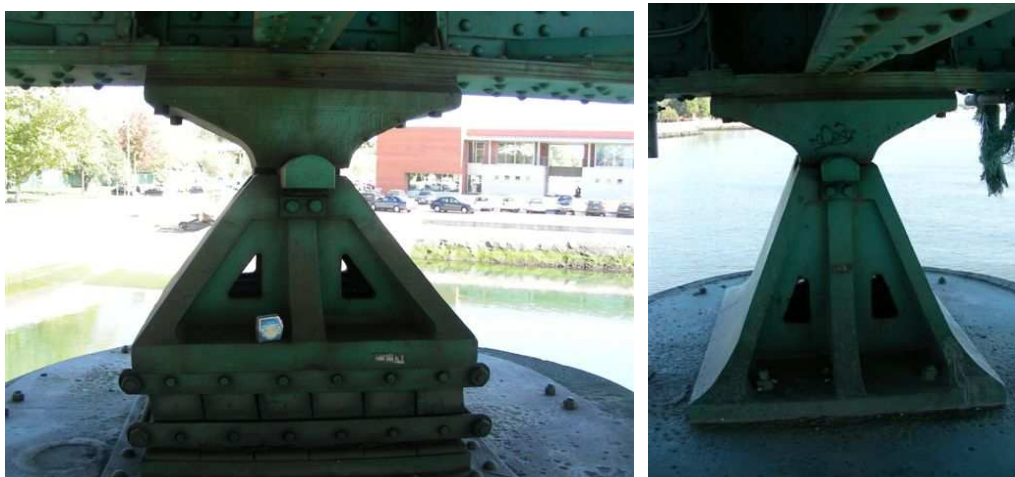
Fig. 3 – Aparelhos de apoio do tipo móvel e do tipo fixo.
