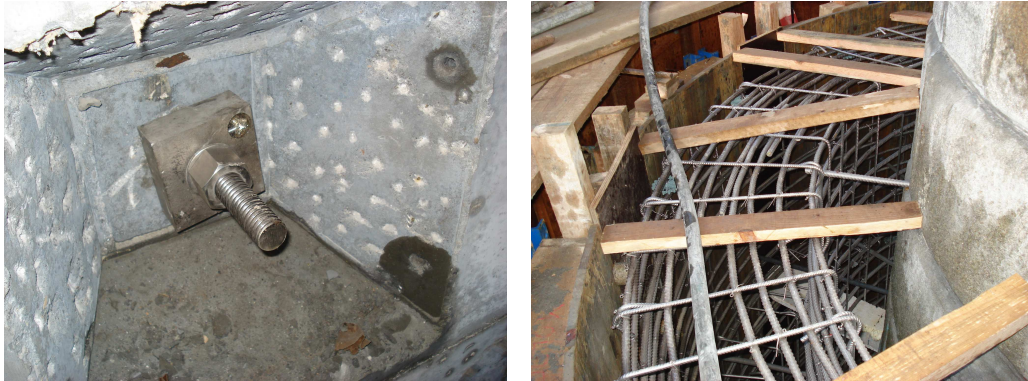
Fig. 9 – Armaduras em aço inox
