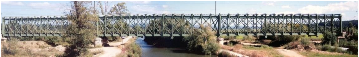
Fig. 3: Alçado da Ponte antes da reabilitação de 2003
