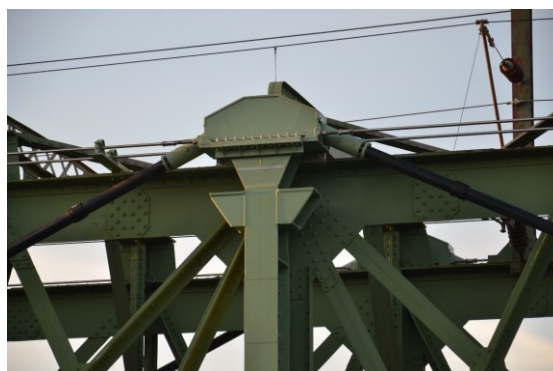
b) Vista de um desviador superior sobre um apoio sobre um pilar
