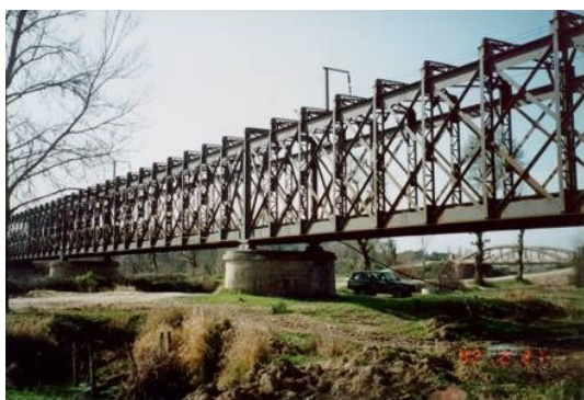
a) Vista exterior da estrutura
