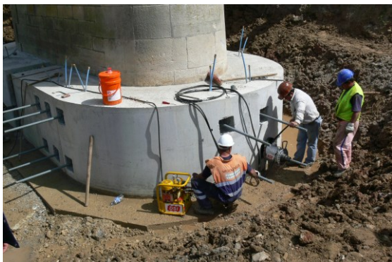
a) Maciço de interligação entre micro-estacas e o pilar (fase de tensionamento das barras de ligação)
