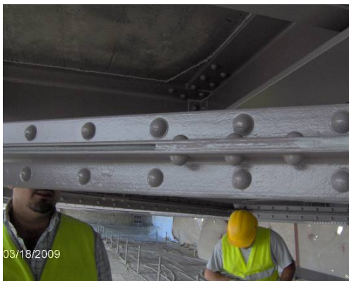
Figura 17 – Ponte da Raposa – Selagem das juntas entre perfis metálicos e entre perfis metálicos e betão com mastique após antes da aplicação da camada final da pintura
