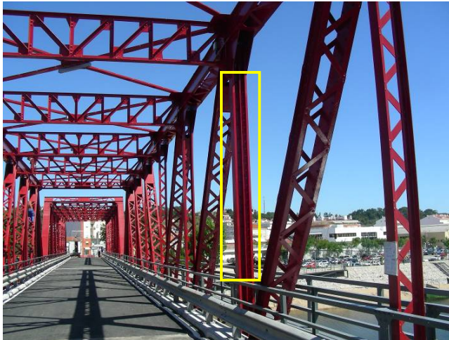
Figura 15 – Ponte General Teófilo Trindade - Reforço dos montantes das vigas principais com cantoneiras soldadas aos banzos
