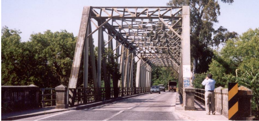
Figura 2 – Ponte da Raposa sobre a Ribeira de Muge
