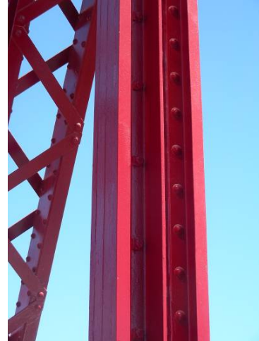
Figura 15 – Ponte General Teófilo Trindade - Reforço dos montantes das vigas principais com cantoneiras soldadas aos banzos
