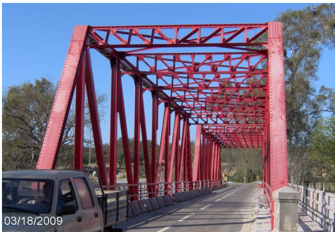
Figura 19 – Vista geral da Ponte da Raposa após reabilitação
