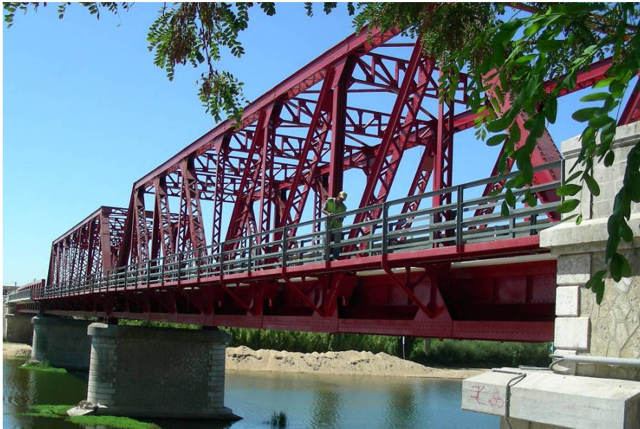
Figura 18 – Vista geral da Ponte General Teófilo Trindade após reabilitação
