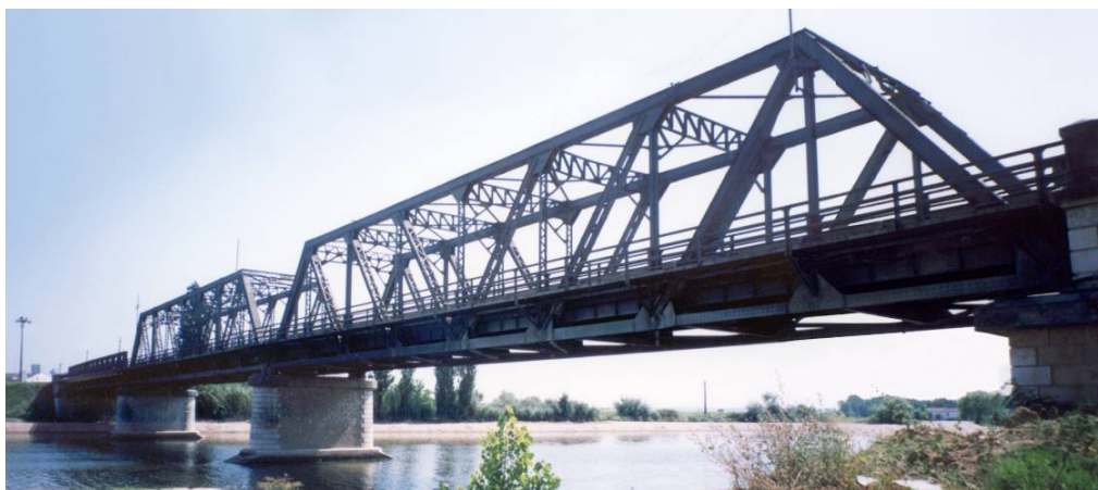
Figura 1 – Ponte General Teófilo Trindade sobre o Rio Sorraia
