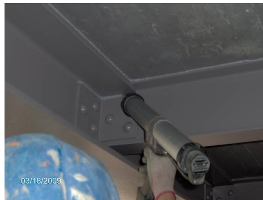
Figura 17 – Ponte da Raposa – Selagem das juntas entre perfis metálicos e entre perfis metálicos e betão com mastique após antes da aplicação da camada final da pintura
