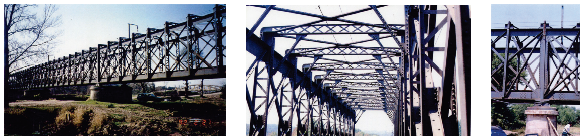
Figura 1 - Vista geral da ponte e pormenores da estrutura metálica
