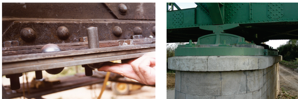
Figura 2 - Substituição de elementos e rebitagem, Aparelhos de apoio fixos após reabilitação
