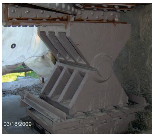
Figura 2 - Aparelhos de apoio móveis nos encontros e fixos nos pilares
