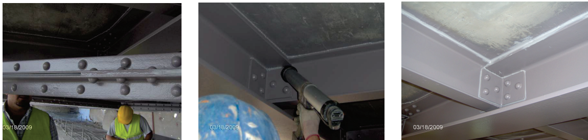
Figura 3 - Selagem entre perfis e primário
