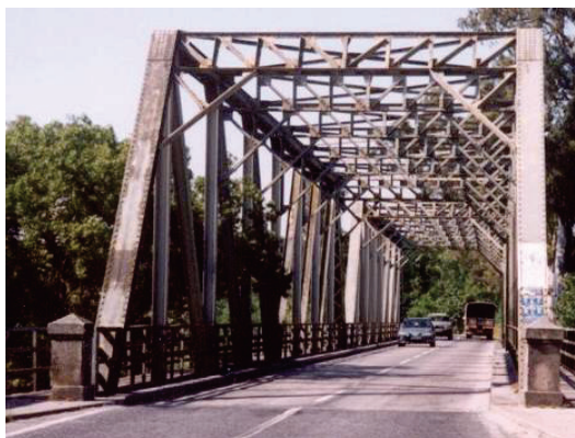
Figura 1 - Vistas gerais da ponte
