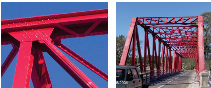
Figura 4 - Aspecto final do tabuleiro da ponte após intervenção
