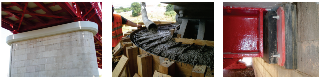
Figura 4 - Cintagem do topo do pilar e batentes de elastómero no topo das vigas, nos encontros
