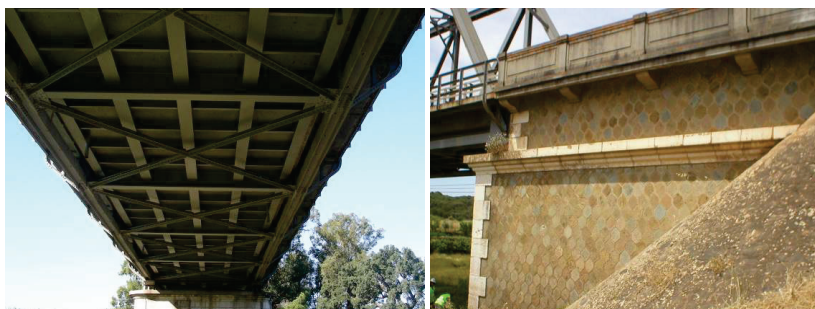
Figura 2 - Vista da face inferior do tabuleiro e encontro
