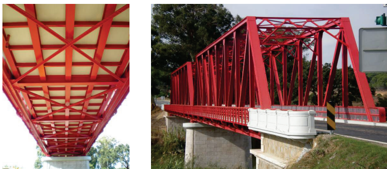
Figura 3 - Vistas da ponte após reabilitação geral
