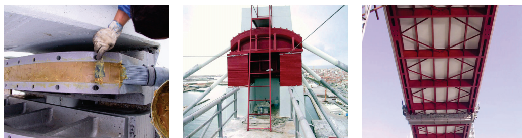
Figura 5 - Reabilitação da tabuleiro, dos tirantes e das selas
