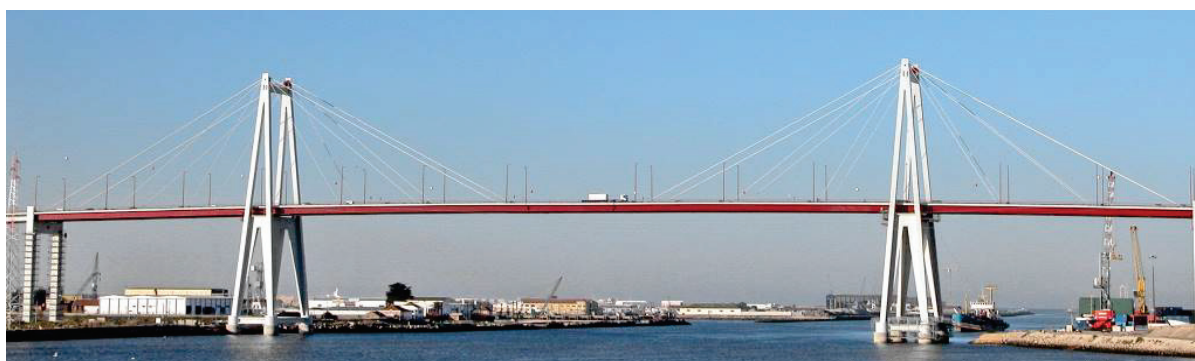
Figura 1 - Vista geral da ponte
